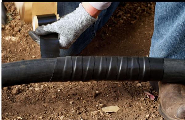
Quando si verificano danni più significativi in cui una parte della guaina del cavo è strappata, per prima cosa controllare se gli strati interni del cavo sono intatti. Quindi procedi come segue:
